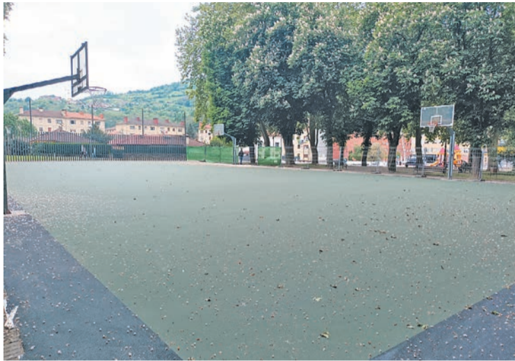
Pista deportiva Joaquín Blume tras su rehabilitación.
