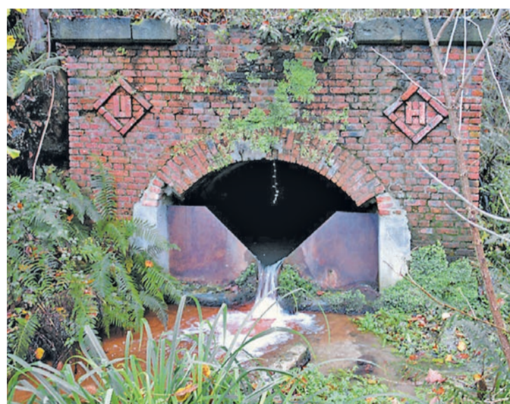
Socavón de la mina "LA JUSTA".
